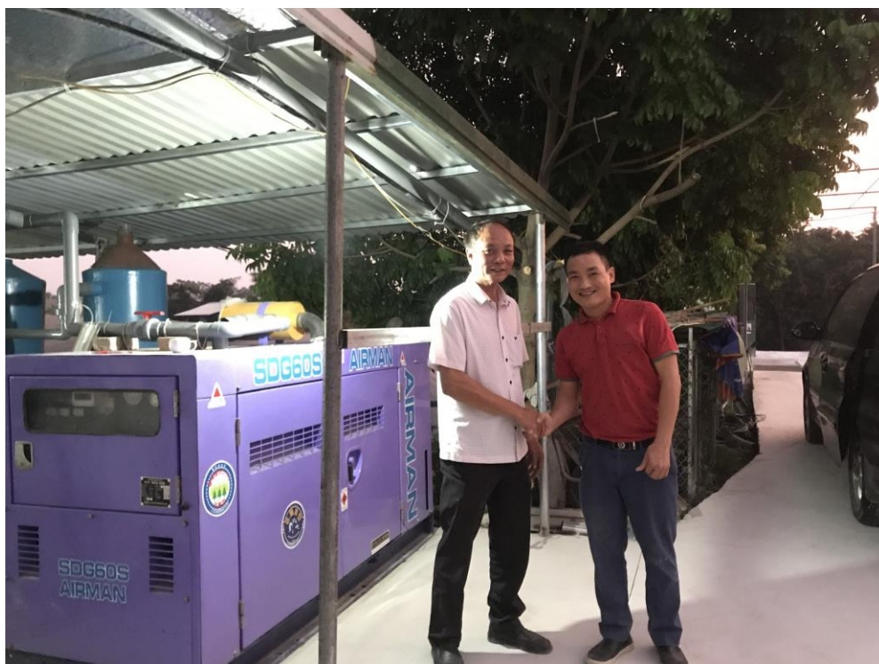
KS. Phạm Đức Thọ (phải) và chủ trang trại ở thôn Kim Nê, xã Thanh Bình, huyện Chương Mỹ, TP. Hà Nội cạnh chiếc máy phát điện biogas mới được EGreen cải tiến. Ảnh: NVCC
