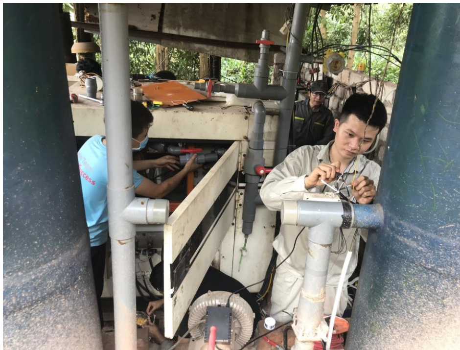
Cải tạo máy phát điện diesel thành máy phát điện biogas. Ảnh: EGreen
